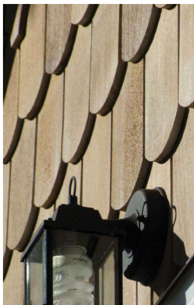
Detalle del revestimiento de pared
