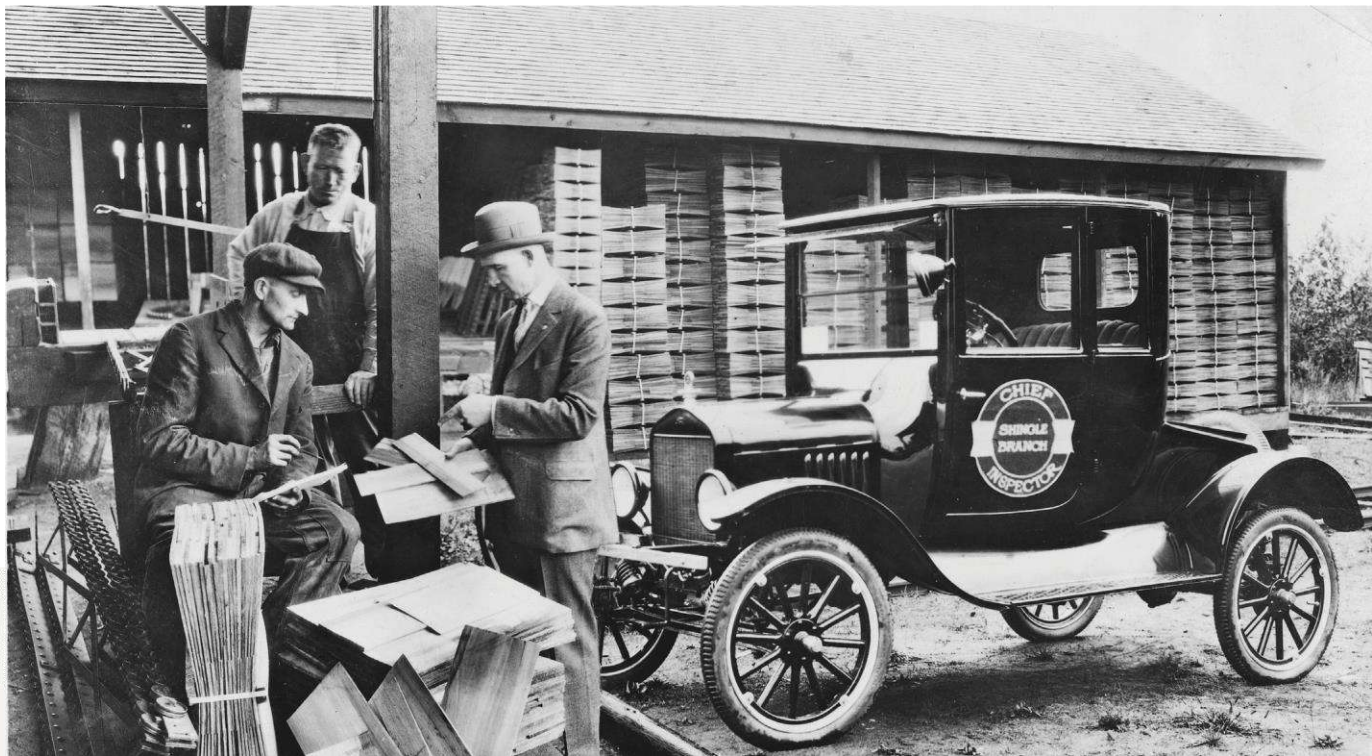
Década de 1920: El inspector jefe Fred Monte inspeccionando un producto
